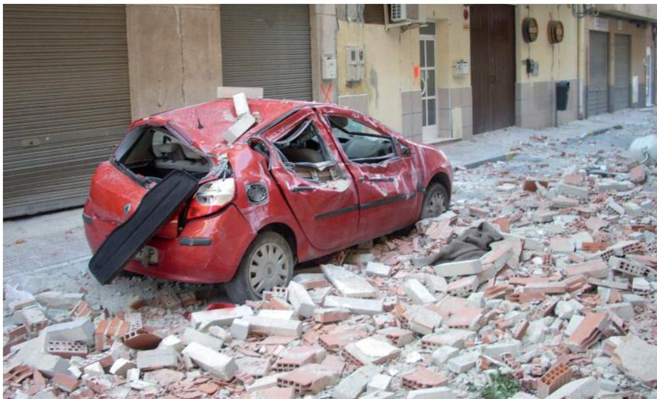
Un automóvil dañado por la caída de parapetos de cubierta en la calle Galicia | I.G.N.
