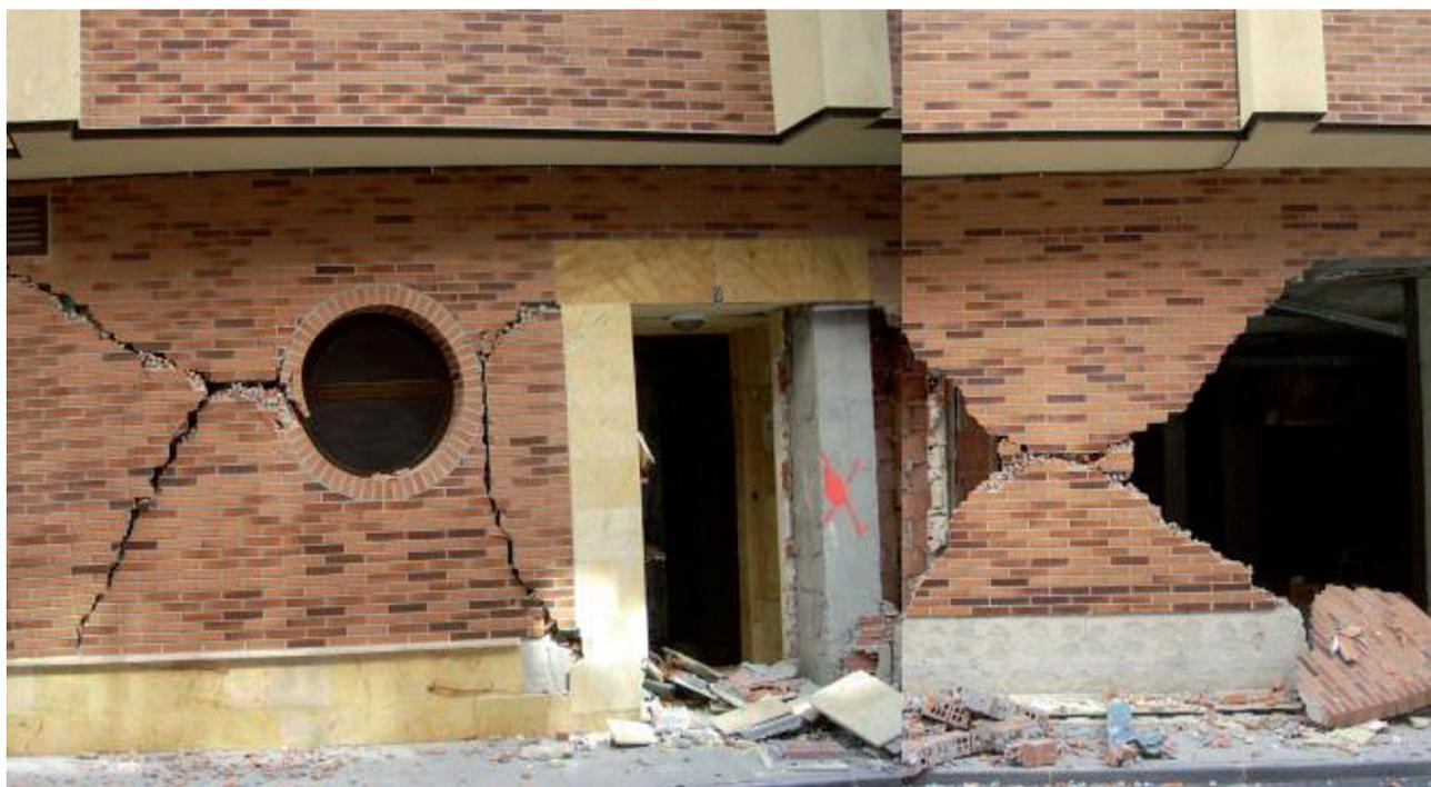
Daños por cortante en el cerramiento no estructural de planta baja de un edificio de viviendas. El cerramiento ha entrado en carga resistiendo los esfuerzos horizontales de la estructura, por lo que muestra los mismos mecanismos de daño que las estructuras murarias, fallando por cortante con grietas en forma de aspa | I.G.N.
