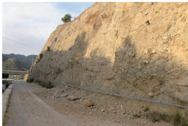
Desprendimientos superficiales en un talud de la carretera del canal Tajo-Segura | I.G.N.
