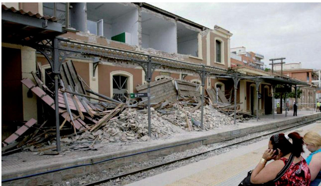
Vuelco de estructura muraria de fábrica de ladrillo en la estación de Lorca | I.G.N.
